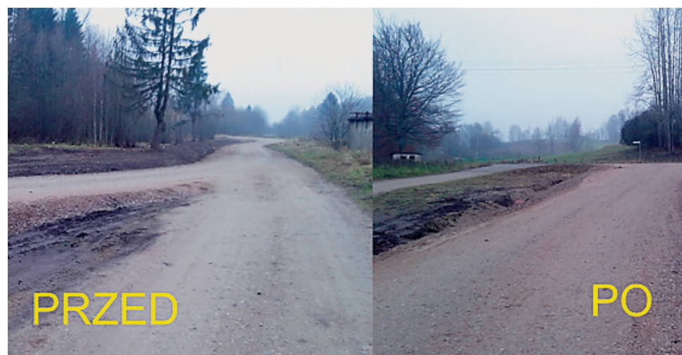
10. Zakończyła się budowa drogi dojazdowej w miejscowości Górne (do kościoła parafialnego). Roboty obejmowały przede wszystkim wykonanie rowu wraz z pogłębieniem istniejącego, wycinkę krzaków, budowę przepustów oraz wykonanie nawierzchni z kruszywa gr. 20 cm. Wartość inwestycji to 62 tys. zł.
