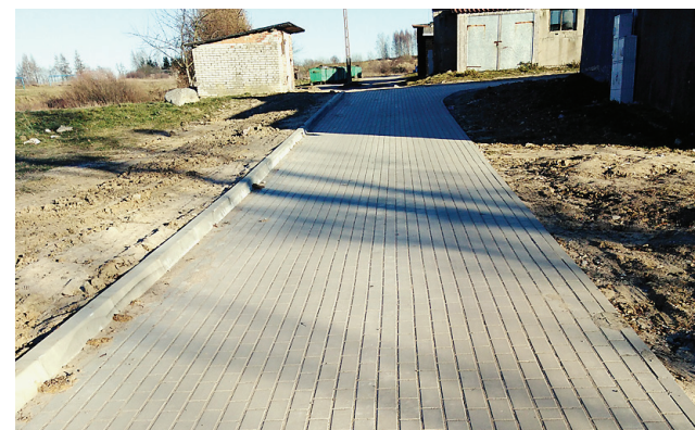
Utwardzenie drogi do garaży w miejscowości Grabowo - koszt 11 295 zł
