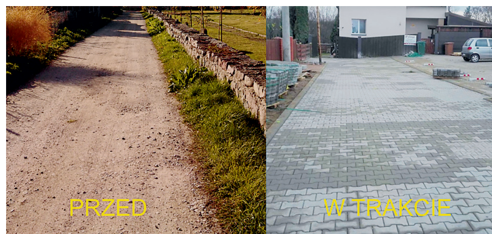
11. Prace na ul. Nad Jarem zostały zakończone. Polegały one na wyłożeniu ulicy kostką brukową oraz na budowie kanalizacji deszczowej. Wartość inwestycji to 157,7 tys. zł.
