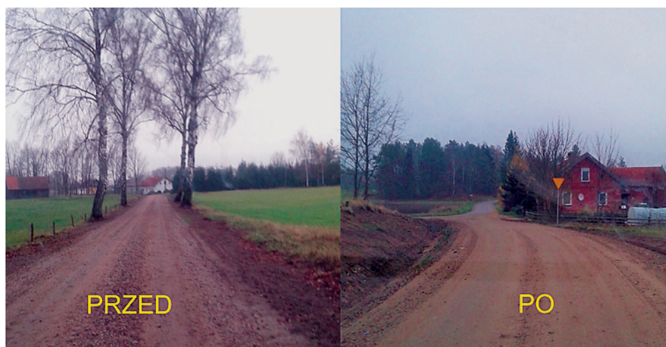
9. Zakończył się remont drogi Janów - Rożyńsk Mały. Roboty polegały przede wszystkim na wykonaniu pobocza i rowu, budowie przepustu oraz wykonaniu nawierzchni z kruszywa gr. 30 cm. Koszt remontu niespełna kilometrowego odcinka to 57,3 tys. zł.
