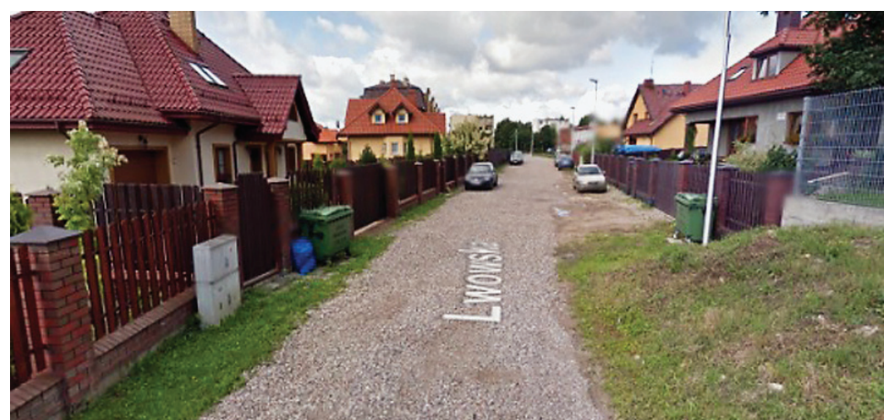
12. Trwają prace przy przebudowie ul. Lwowskiej w Gołdapi. Nawierzchnia żwirowa zostanie zastąpiona kostką brukową, a także wykonany będzie chodnik. Koszt tej inwestycji to ok. 387,5 tys. zł.
