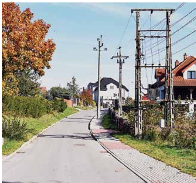
Przebudowa ul. Stanisława Mikołajczyka- 270 085,54 zł. Dofinansowane z budżetu państwa w ramach tzw. opłaty uzdrowiskowej, kwotą 212 216,75 zł, przy wkładzie własnym gminy 57 868,79 zł. Prace polegały na przebudowaniu nawierzchni żwirowej na nawierzchnię asfaltową. Wykonano również chodniki i zjazdy z kostki betonowej.
