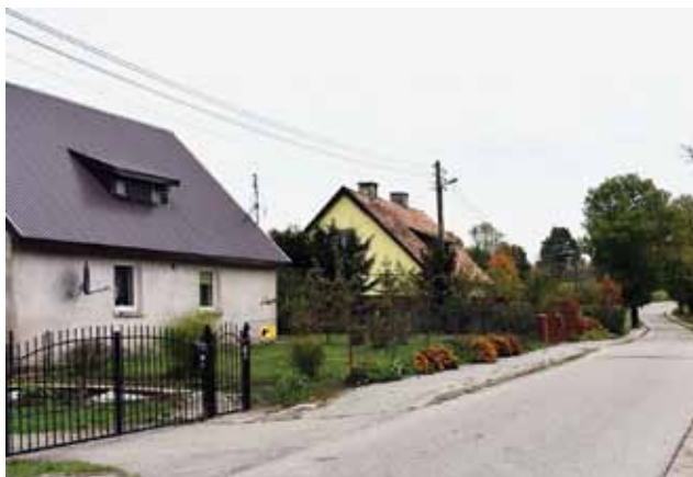
Budowa chodnika w Kolniskach. Koszt: 19 600 zł.
