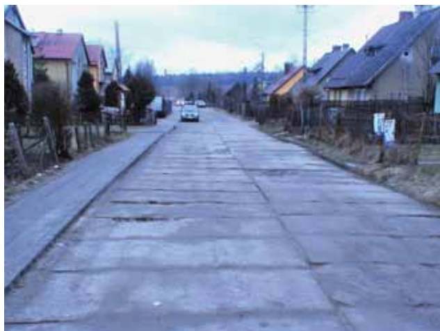
Przebudowa drogi w Galweciach. Droga łącząca się z drogą wojewódzką nr 651 posiadała nawierzchnię z drogowych płyt betonowych. Płyty te usunięto i wykonano nawierzchnię bitumiczną. Ustawiono dwa znaki drogowe zasilane solarnie i wyznaczono zatokę autobusową. Koszt zadania: 631 159,78 zł. Dofinansowanie w wysokości 308 803 zł pozyskano z Programu Rozwoju Gminnej i Powiatowej Infrastruktury Drogowej.
