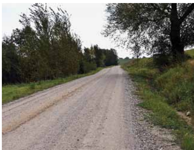
Miejscowość Konikowo- bieżące utrzymanie dróg
