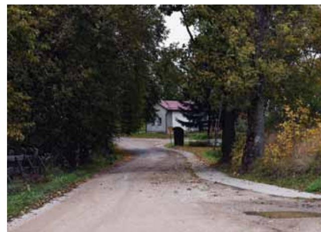
Remont i budowa dwóch chodników w Wilkasach. Koszt: 20 078,72 zł
