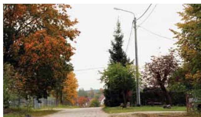
Instalacja oświetlenia w Kośmidrach na odcinku drogi łączącej wieś z osiedlem. Koszt: 15 216,00 zł.
