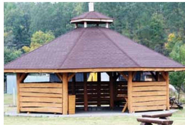
Budowa wiaty rekreacyjnej w Niedrzwicy. Koszt: 18 369,21 zł.
