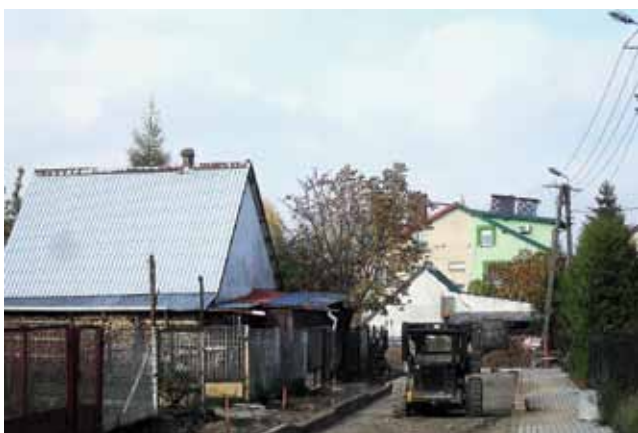
Przebudowa drogi we wsi Wronki Wielkie. Zdemontowano płyty betonowe. Wykonano nową nawierzchnię jezdni i skrzyżowań. Koszt: 170 000 zł.
