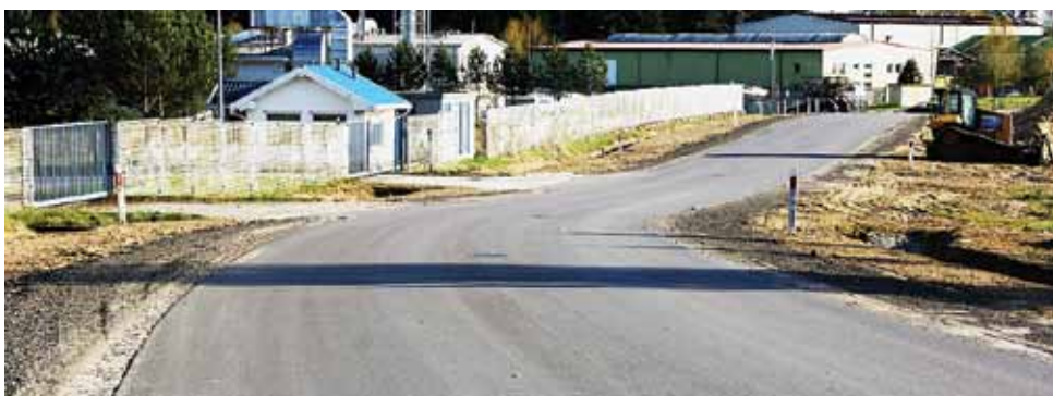
Na terenie podstrefy Gołdap w 2015 roku wykonano odcinek ul. Ekonomicznej o długości 310m o nawierzchni asfaltowej. Umocniono również skarpy ul. Strefowej. Wartość robót wyniosła 259 388,86 zł.
