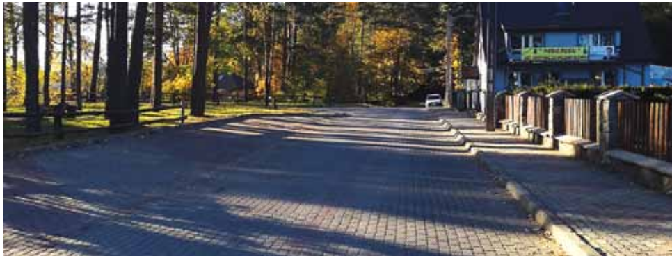
Przebudowa drogi wjazdowej do budynku przy ul. Paderewskiego 17 i 29A- 27 157,72 zł. Wykonano na niej nawierzchnię z betonowej kostki brukowej.
