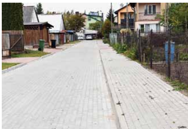
Przebudowa drogi we wsi Wronki Wielkie. Zdemontowano płyty betonowe. Wykonano nową nawierzchnię jezdni i skrzyżowań. Koszt: 170 000 zł.
