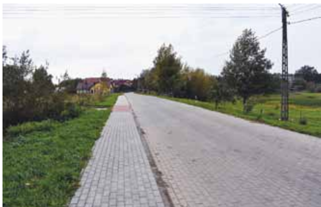
Budowa chodnika oraz oświetlenie drogowe w Kozakach. Koszt: 19 999,41 zł.
