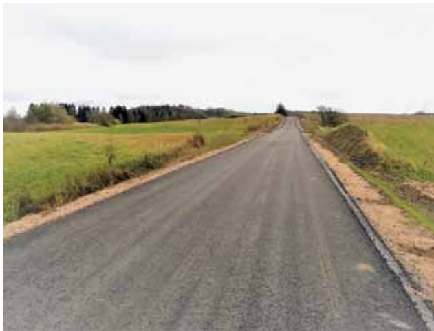
Przebudowa drogi gminnej Rostek – Kośmidry. Modernizacja polegała na poszerzeniu jezdni, położeniu nowej nawierzchni bitumicznej i wykonaniu skrzyżowań i zjazdów. W miejscowości Rostek oddano do użytku chodnik oraz kanalizację deszczową. Koszt zadania: 3 594 919 zł. Dofinansowanie w wysokości 1 955 756,00 zł pozyskano z Programu Rozwoju Obszarów Wiejskich na lata 2014-2020.
