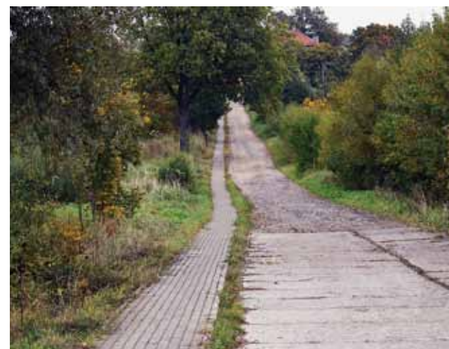
Wykonanie chodnika we wsi Galwiecie
