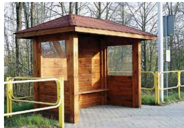
Budowa wiat przystankowych w Galwiciach, Marcinowie, Mażuciach oraz w Żelazkach. Koszt: 16 449,63 zł.
