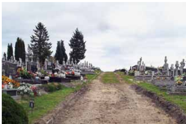
Budowa alejek na cmentarzu w Grabowie- 168 000 zł. Rozpoczęcie prac.
