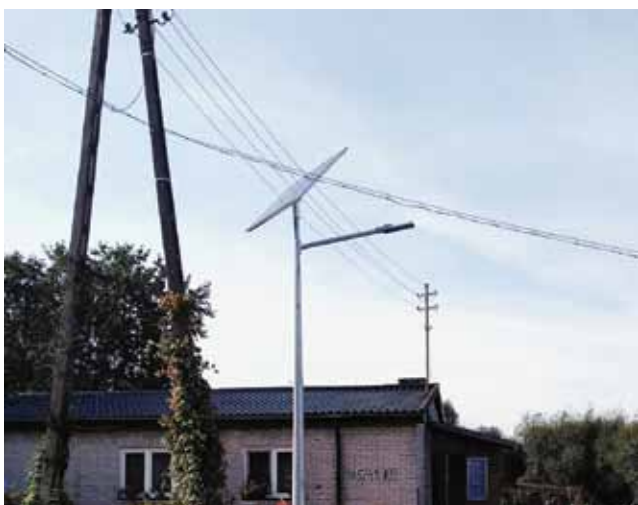
Instalacja dodatkowego oświetlenia w sołectwie Główka. Zamontowano 1 lampę oświetleniową w Boćwinie oraz 1 lampę w miejscowości Dąbie. Koszt: 8 413,20 zł.
