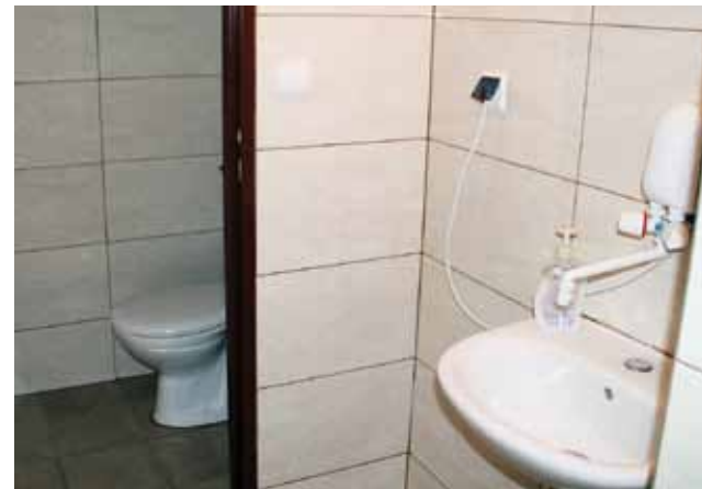
Świetlica w Skoczach (remont toalety)- 20 684,77 zł.
