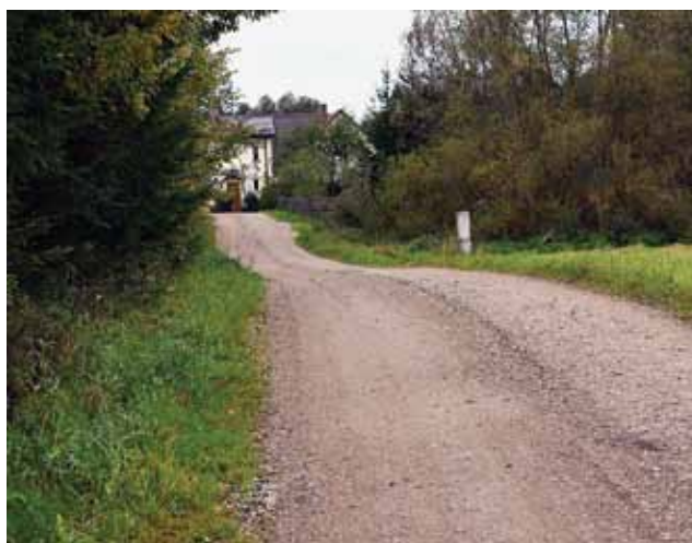
Utwardzenie drogi we wsi Dziegiele
