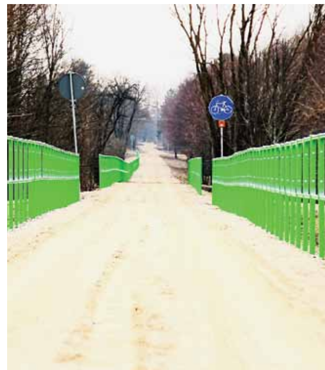
Trasy rowerowe w Polsce Wschodniej (RPO WM 2014-2020)- 5 177 979,16 zł, z czego ze środków unijnych pochodziło 4 919 080,17 zł, ze środków województwa 258 898,99 zł. Gmina ze swojej strony zapewniła pracę w komisjach, odbiór robót i opłacanie faktur. W ramach prac wykonano trasę rowerową o długości 12,571 km, w tym 564 m o nawierzchni z betonu asfaltowego, 11 992 m z nawierzchni naturalnej oraz kładkę o długości 15 m nad rzeką Gołdapą. Do tego zbudowano trzy tzw. MORy, czyli miejsca obsługi rowerzystów – w Boćwinie, Jabłońskich i Rakówku.
