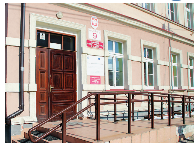
Wniosek zakłada przeprowadzenie termomodernizacji budynków Ośrodka Pomocy Społecznej i SP 3
