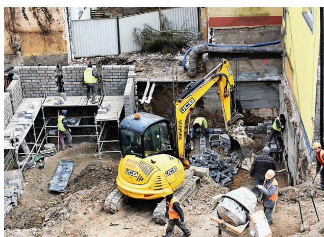
Ruszyły prace nad rozbudową gołdapskiego Domu Kultury
